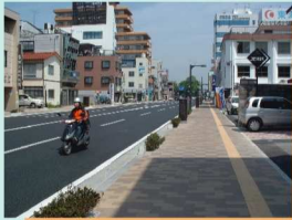
電線類の地中化：宇都宮市
