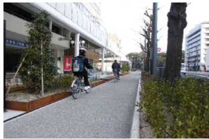
道路空間の再配分（自転車道の設置）
